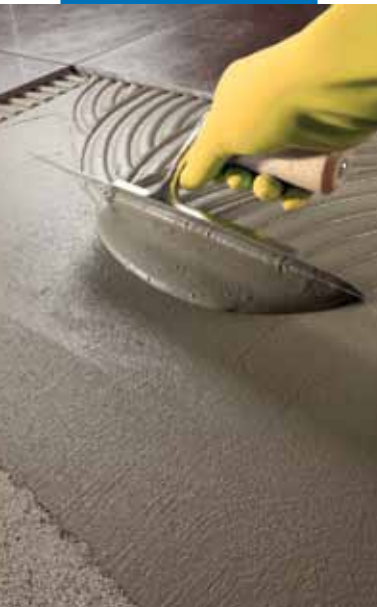
Полагане на Kerabond T-R върху подове
