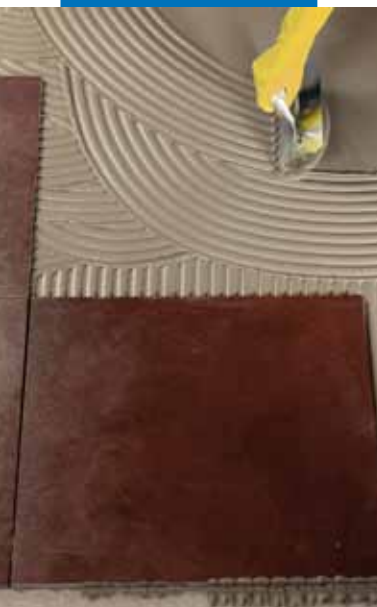
Полагане на Kerabond T-R върху стени
